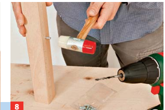
8 Bohren Sie die Löcher vor (das verhindert ein Ausreißen des Holzes), und schlagen Sie die Bodenträgerstifte ein
