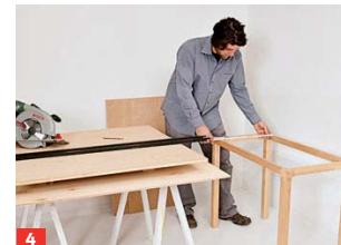
4 Nehmen Sie nun Maß für den Zwischenboden, auf dem später die Stühle abgelegt werden können. Für gerade ...
