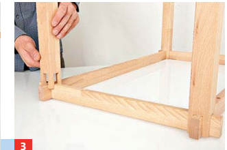
3 Stecken Sie die vier Tischbeine auf die Eckverbindungen des Mittelteils. Mit Inbusschrauben fixieren
