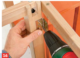
16 ... bzw. den Zargen verschrauben. Nun werden die beiden seitlichen Tischbeine mit Klappscharnieren befestigt
