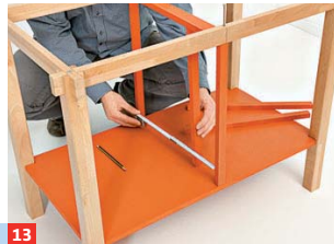
13 Jetzt werden die Fächer gebaut: Übertragen Sie die Breite der zusammengeklappten Stühle auf den Einlegeboden
